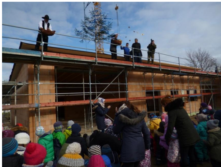
„Hebauffeier“ vom neuen Kindergarten 2017
